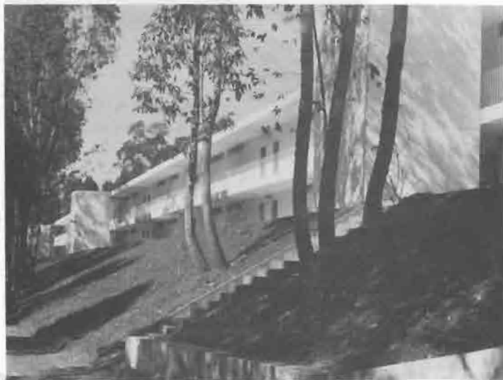
H-8: Prédio de apartamentos do 3º ano
