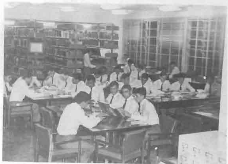
Uma olhadinha nas obras da biblioteca.
